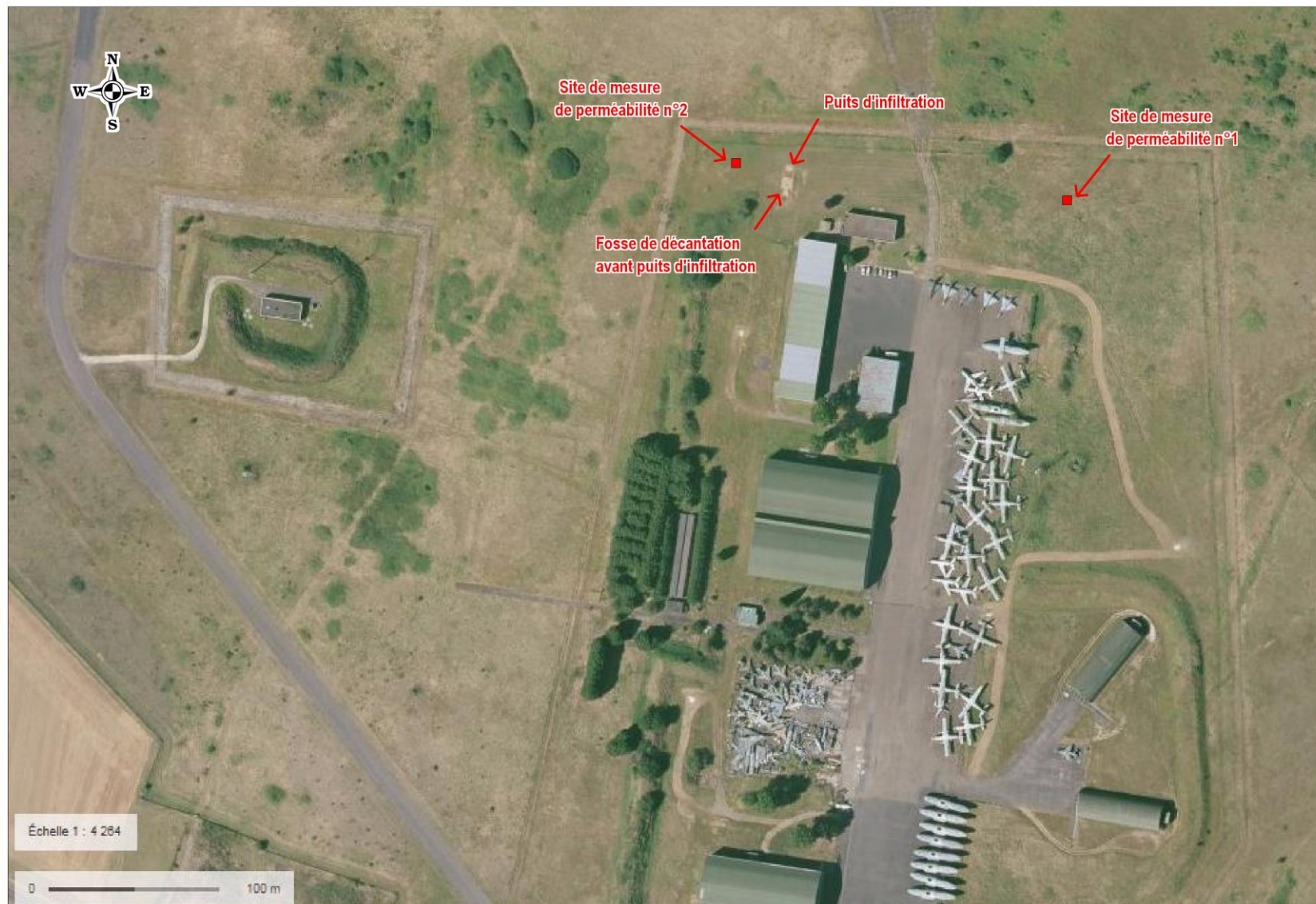
Figure 2 - localisation du puits d'infiltration et des sites de mesure de la perméabilité des sols
